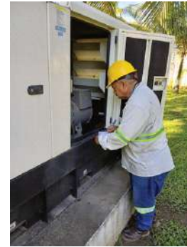
Mantenimiento a generadores eléctricos
