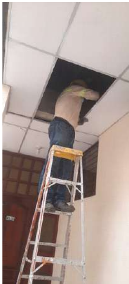
Cambio de cielo falso
