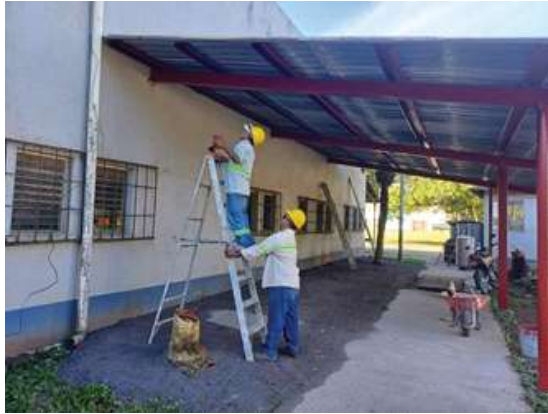
Aplicación de pintura en instalaciones varias.
