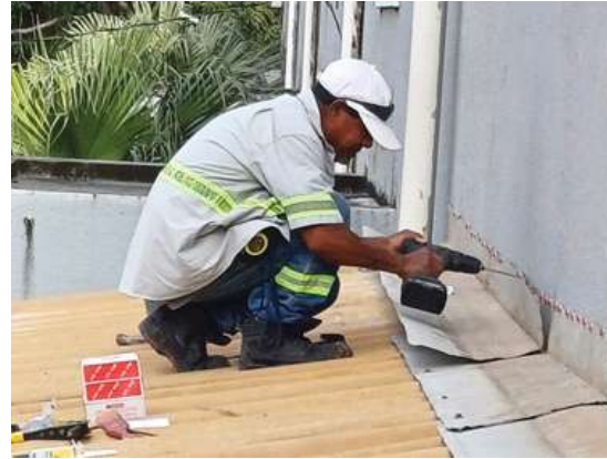
Reparación de techos
