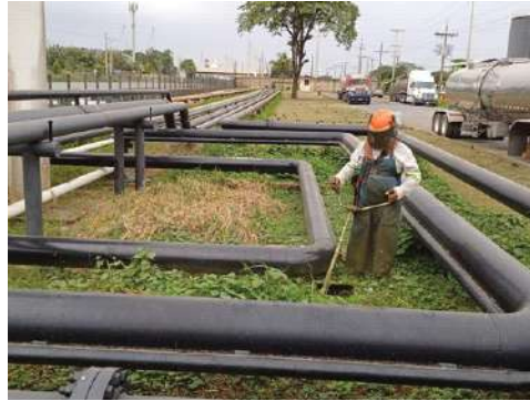
Limpeza en tuberías
