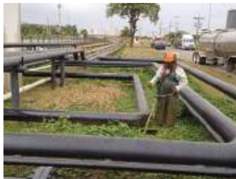
Limpieza en tuberías
