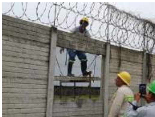
Reparación de muro perimetral
