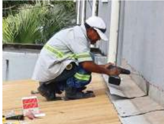
Reparación de techos
