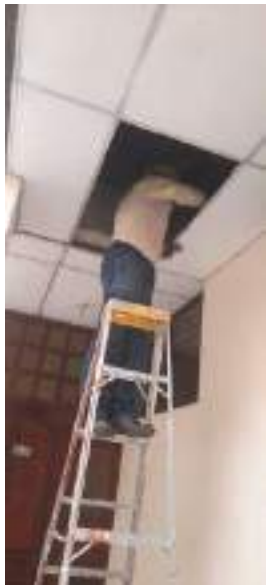
Cambio de cielo falso
