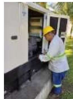
Mantenimiento a generadores eléctricos
