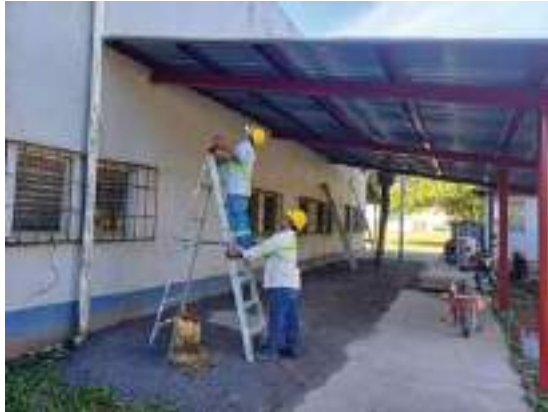
Aplicación de pintura en instalaciones varias.
